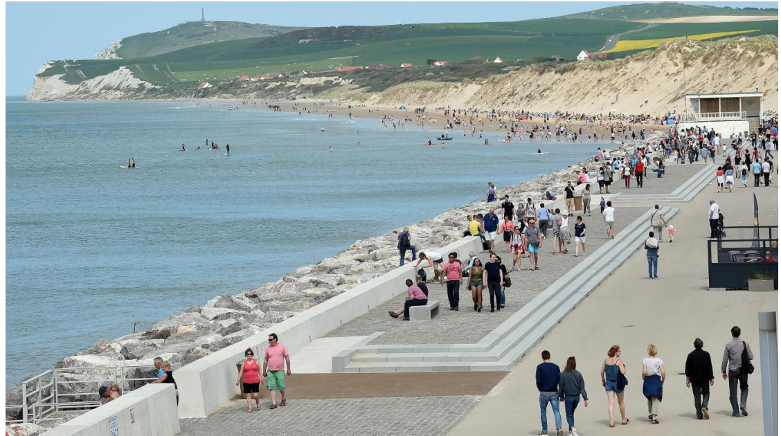
Digue de Wissant
