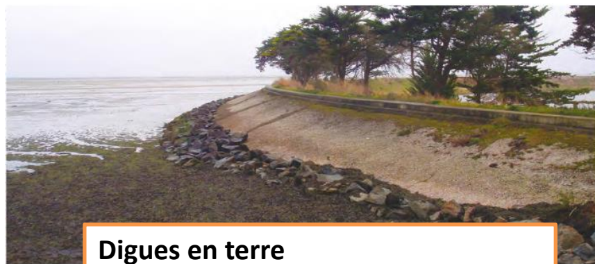
Digue en terre protégeant le polder, Noirmoutier
