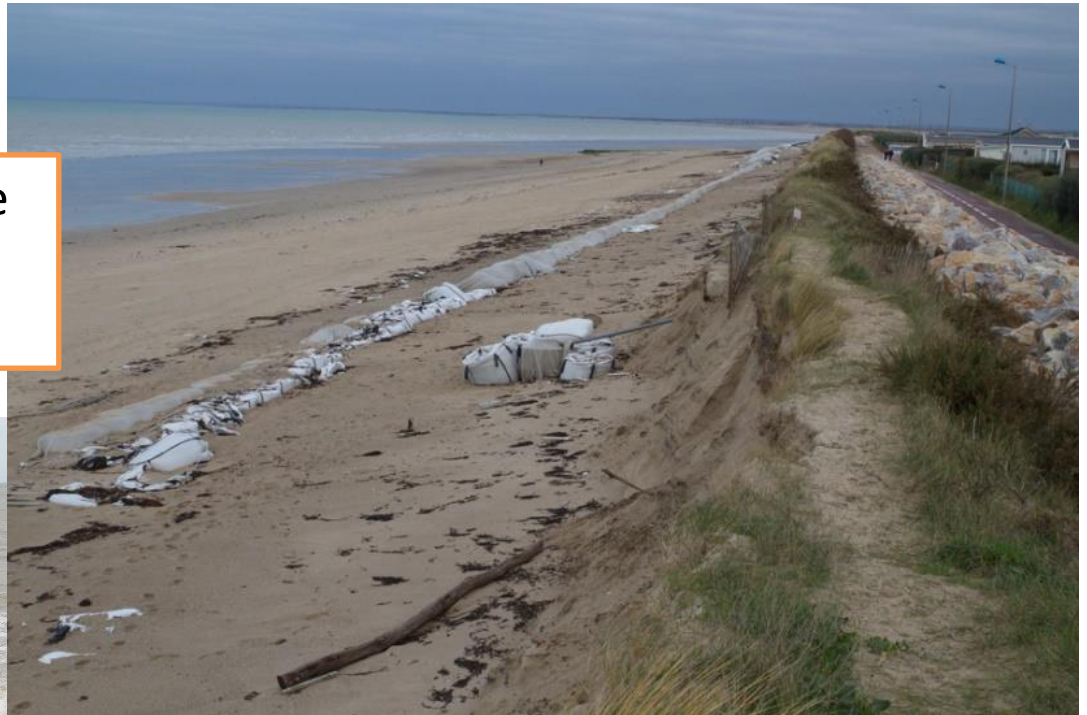
Ouvrage géotextile Gouville sur mer (50)
