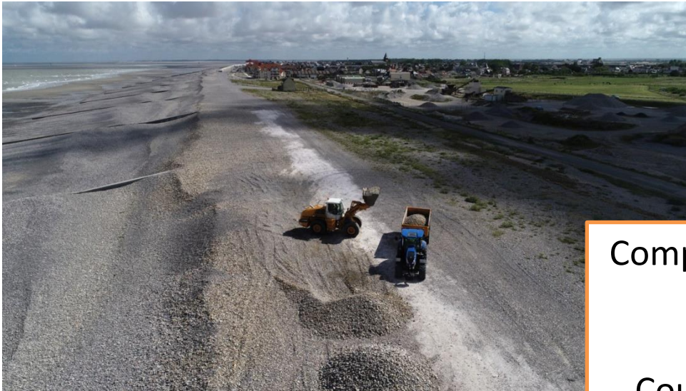
Rechargement galets Cayeux sur mer
