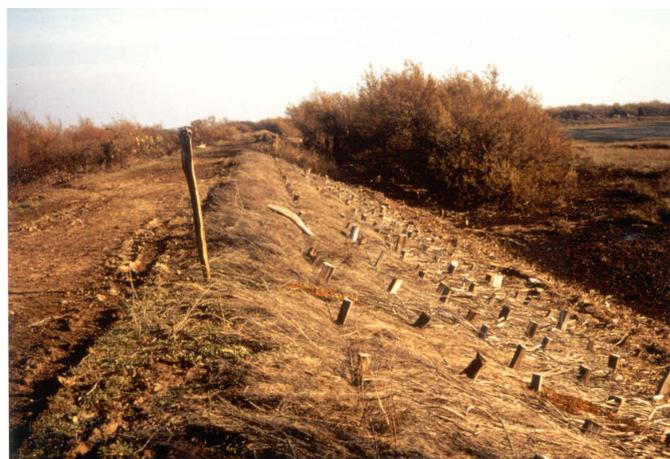
Originellement, la **digue à la mer** a été réalisée avec une faible pente, protégée par une couverture de brande et maintenue par des fils de fer tendus entre des piquets profondément enfoncés. Les pieux, déployés pour lutter contre l'érosion, étaient situés très en avant de la digue et sont désormais les témoins de son recul sous l'effet de l'érosion
