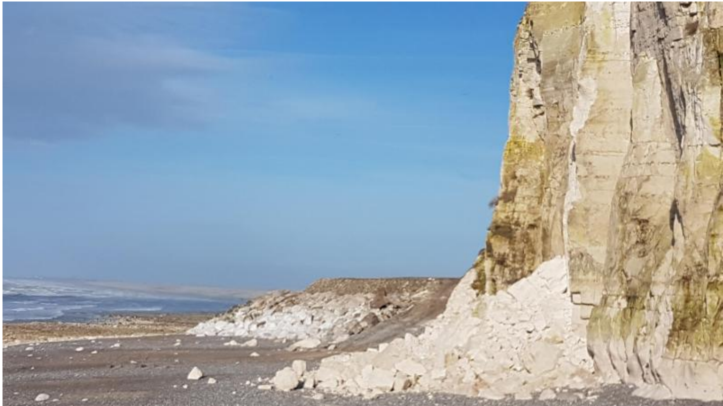
Eboulements à Ault, les éboulis sont aussi source de sédiments
